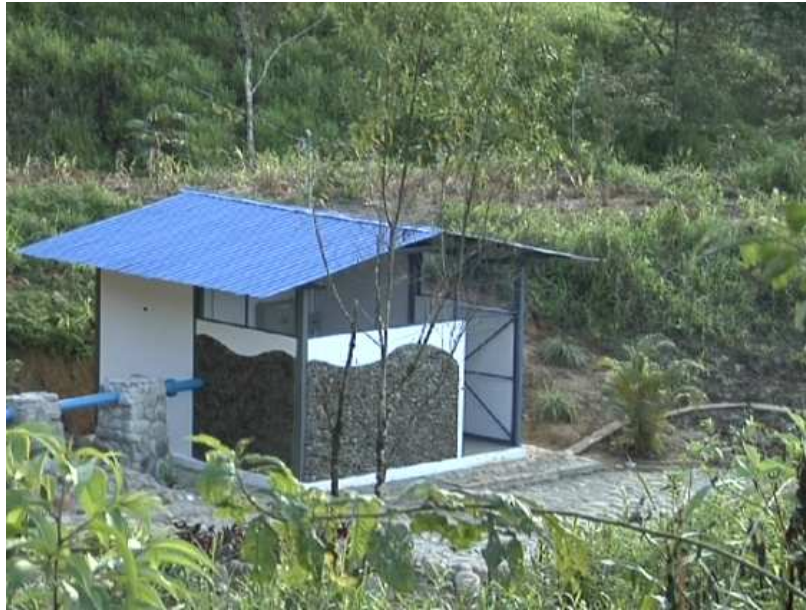
Fotografía 8.1.3-1 Micro Central de Generación Hidroeléctrica Enerentsa
