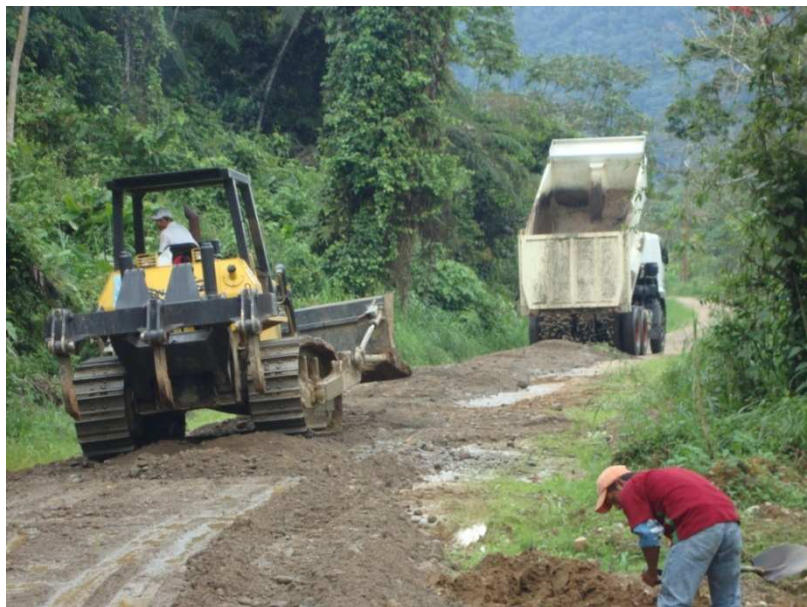
Fotografía 8.1.2-2 Características Vías de Acceso
